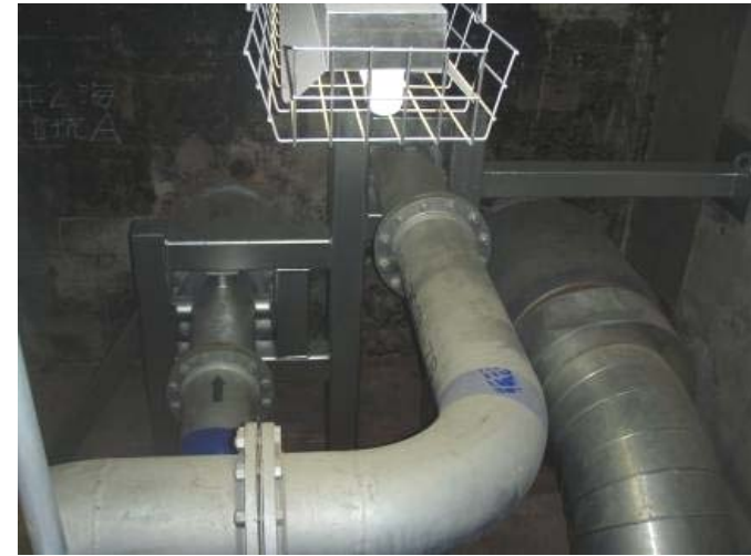
建屋接続部（奥：配管貫通部）
