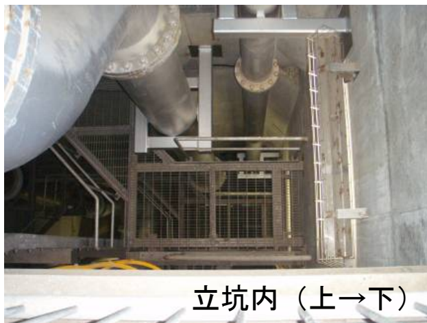
建屋接続部（奥：配管貫通部）
