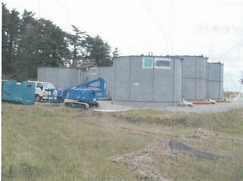
撮影:東京電力株式会社 撮影日:平成23年5月11日10:30頃 場所:貯蔵所(北側) ②丸型タンク(配置図参照)
