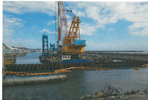
鋼管矢板打設完了状況
