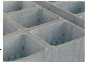
KURION吸着塔を格納す るコンクリートカルバート
