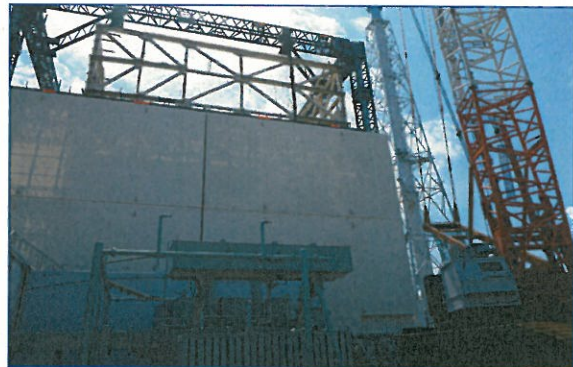
カバー設置状況 (9月14日現在)
