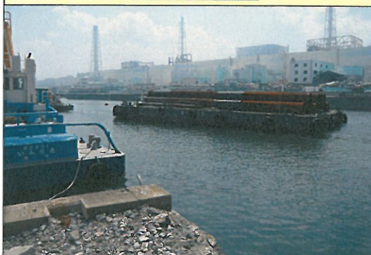
鋼管矢板搬入状況
