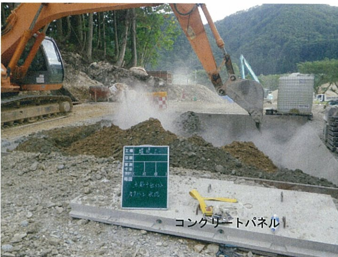
③土砂とセメントの混合(平成24年9月10日撮影)
