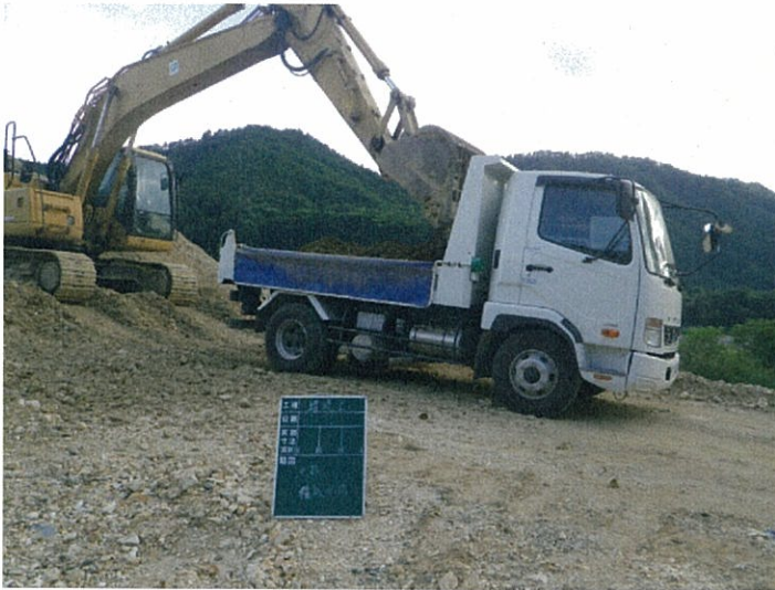
①土砂(基礎掘削土や流出土)積込(平成24年9月10日撮影)
