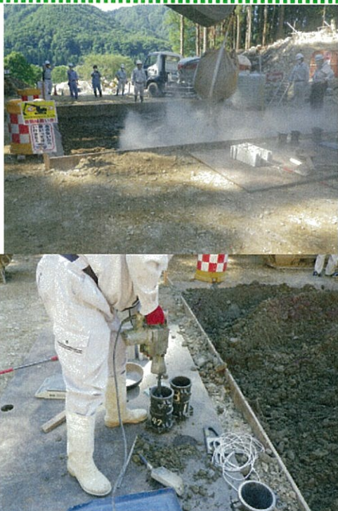
試験施工：左上(セメント投入)、左下(供試体採取)、右(バックホウによる土砂とセメントの混合)(平成24年8月24日撮影)
