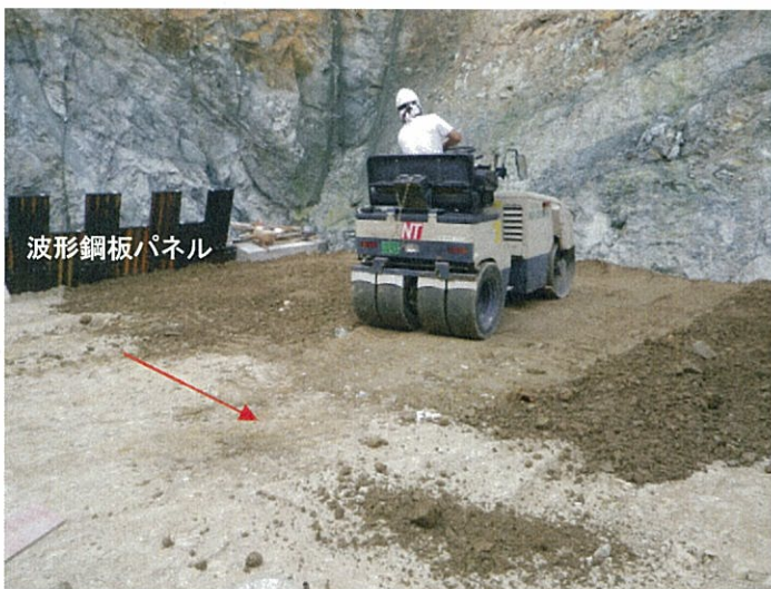
⑤4t級振動ローラによる締固め(平成24年9月10日撮影)
