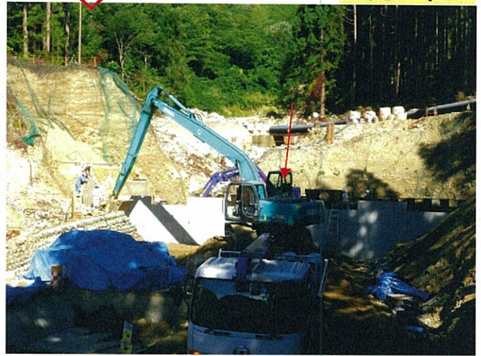
JSウォール堰堤工施工中(平成24年9月27日撮影)
