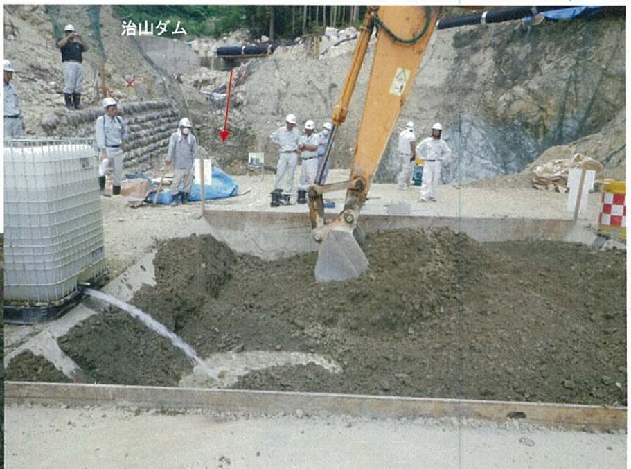
試験施工：左上(セメント投入)、左下(供試体採取)、右(バックホウによる土砂とセメントの混合)(平成24年8月24日撮影)
