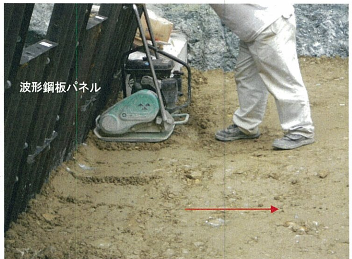
⑥プレートランマによる締固め(平成24年9月10日撮影)
