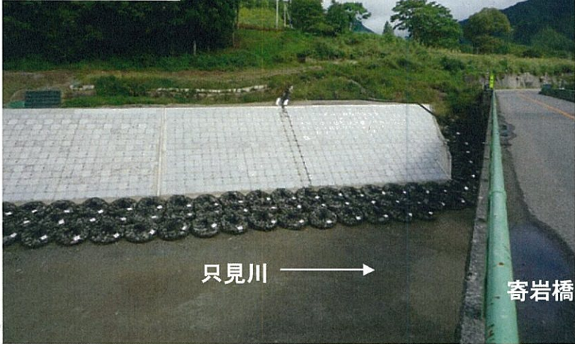
寄岩橋上流左岸の護岸工事完了 (平成24年9月25日撮影)
