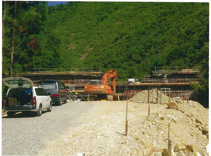
災害関連緊急治山工事の現場状況(平成24年9月14日撮影)
