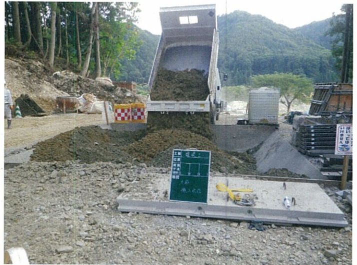
②混合樹へ土砂搬入(平成24年9月10日撮影)
