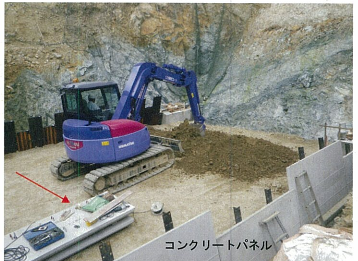
④バックホウによる敷均し(1層30cm程度)(平成24年9月10日撮影)
