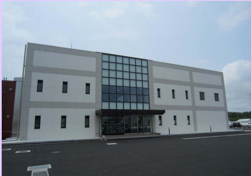
免震重要棟外観
