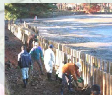
波消しの効果がある乱杭の設置状況
