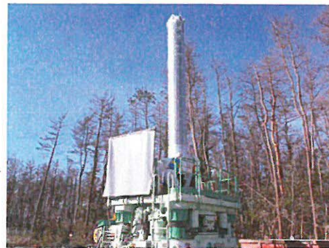
No.10揚水井（B系統）内管設置状況
