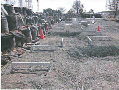
A系統配管基礎設置状況
