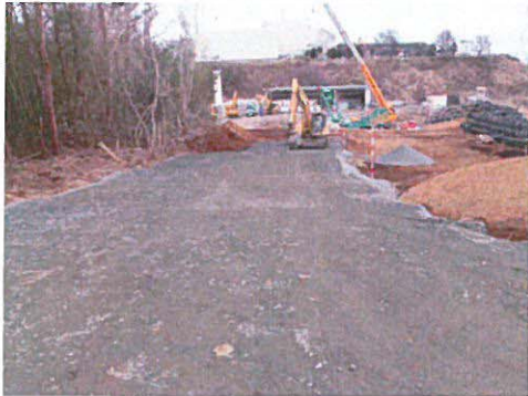
No.7,8揚水井（B系統）ヤード整備状況
