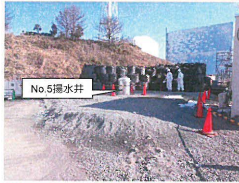
No.5揚水井（B系統）掘削完了状況
