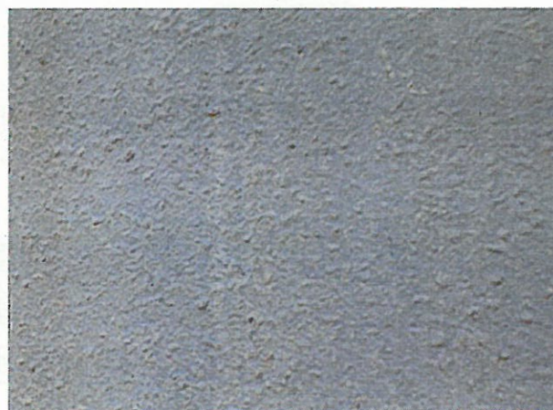
⑤ 西面（外壁）
