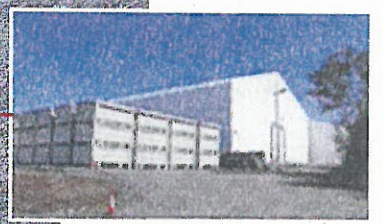
瓦礫保管テント・収納容器
