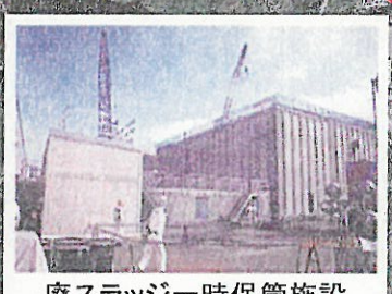
廃スラッジ一時保管施設
