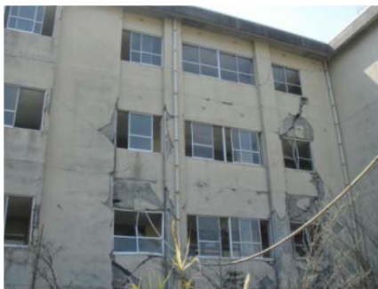
大地震により壁面が崩れた磐城農業高校 校舎 (H23.4 撮影)
