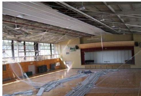
震災直後、天井が崩落した小野高校体育館
