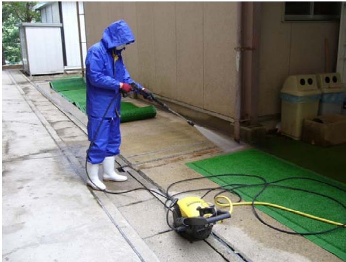
高圧洗浄機による学校施設の除染の様子
