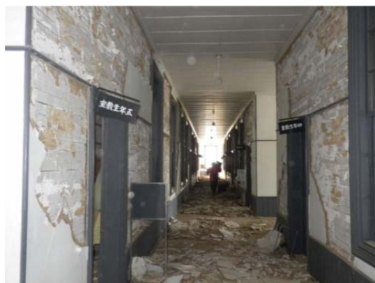
国指定文化財の旧福島県尋常中学校本館 （郡山市）内部の破損の様子
