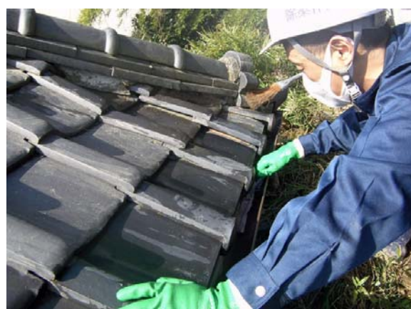
屋根拭き取り状況
