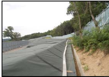
郡山市日和田町高倉地内の 仮置場
