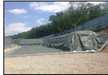
郡山市日和田町高倉地内の 仮置場
