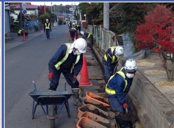
道路側溝堆積物除去
