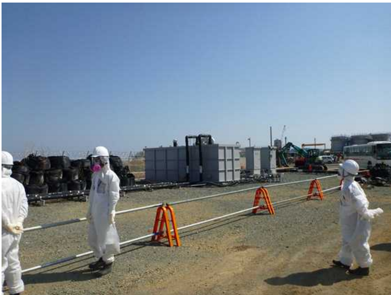
○地下水バイパス 揚水受タンク No.3
