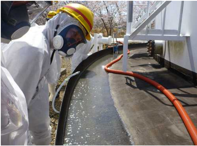
○ろ過水タンク廻り堰の状況
