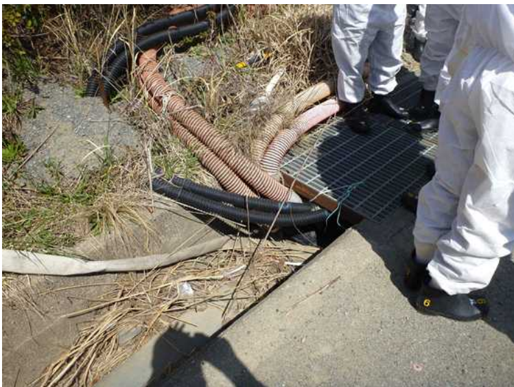
○ろ過水タンクエリア付近のA排水路
