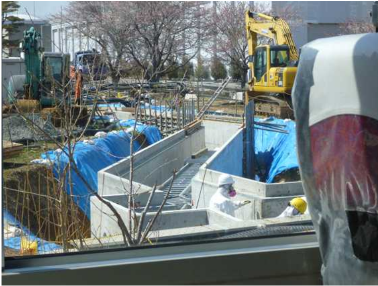
○ケーブルトレンチ本設作業
