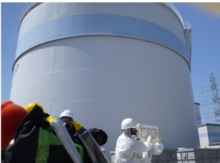
○ろ過水タンク廻り堰からの 雨水溢水に関する現場 説明状況
