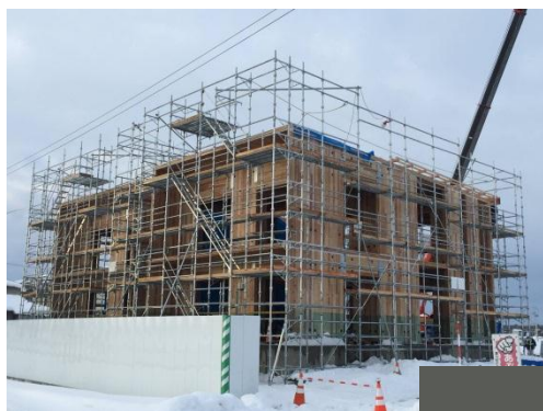
CLTの棟上 1棟2日 (吹雪)
