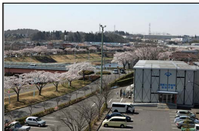
須賀川市役所仮設庁舎
