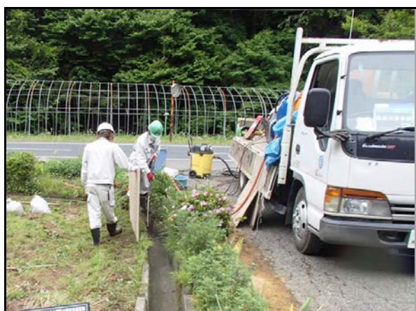
側溝除染作業中
