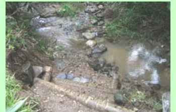
飛び石工施工後の現地の様子
