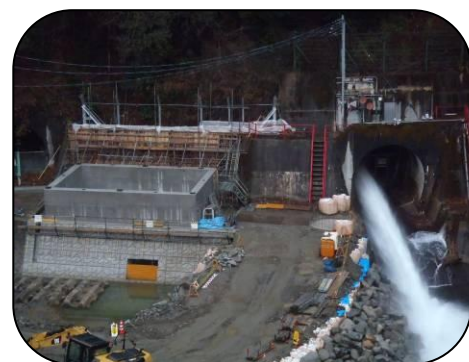
12月29日現在の工事現場
