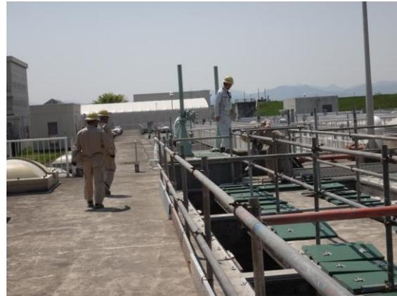
落下防止のための仮設設備点検状況
