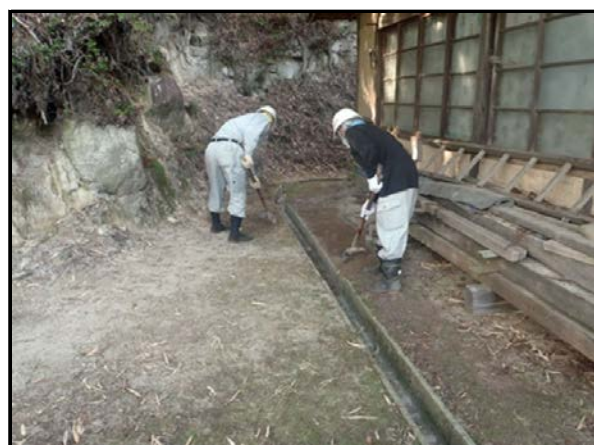
除染実施状況
