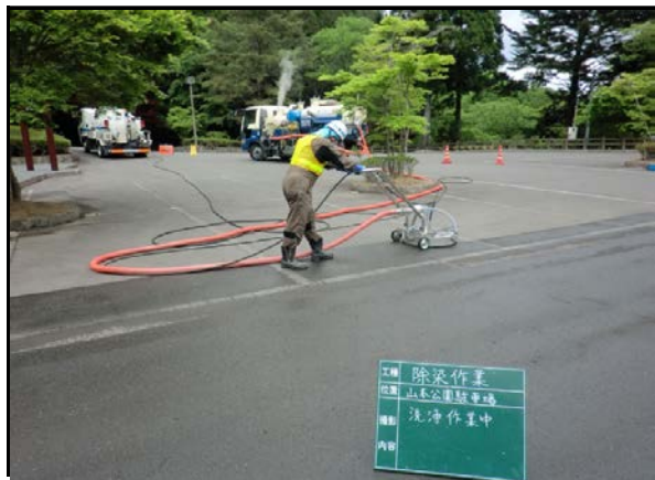
山本公園駐車場除染状況
