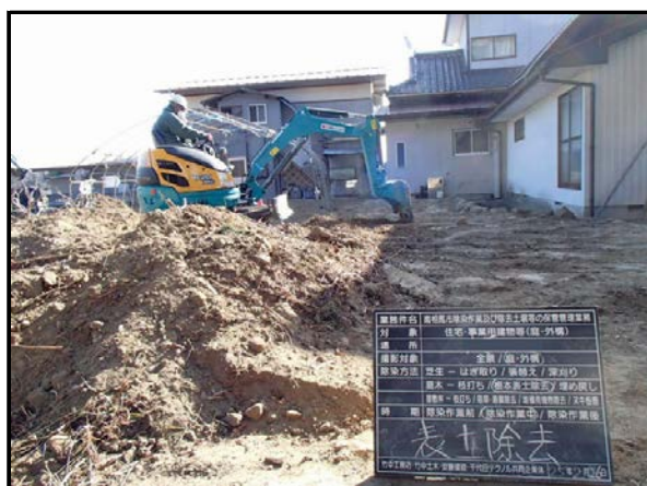
庭除染作業中
