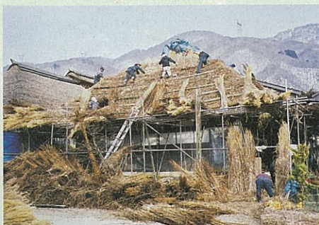
「大内結いの会」による茅葺屋根の葺き替え作業
