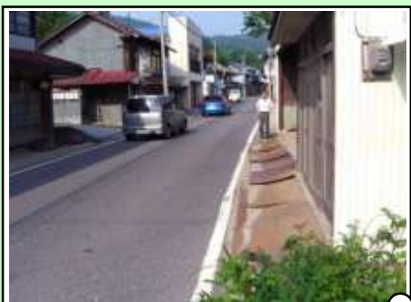
県道小野郡山線の状況
