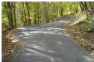
整備された待避所
