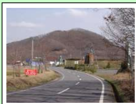
施工前(終点側)
