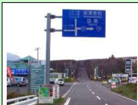
施工前(起点側)
