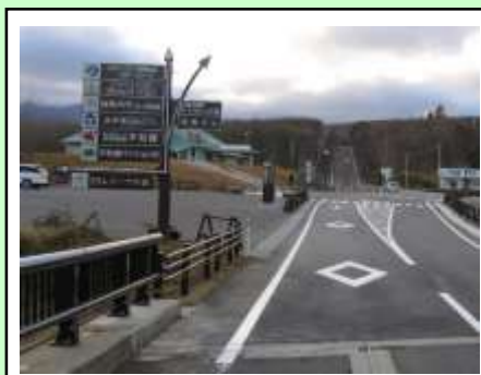
施工後(起点側)
