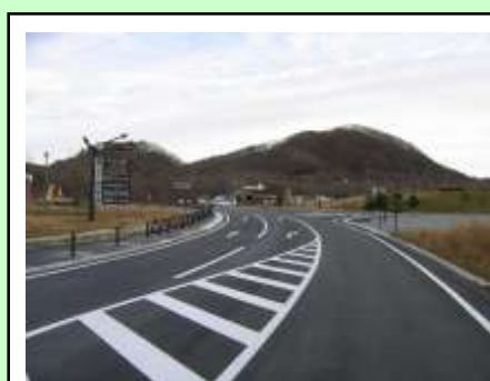
施工後(終点側)
