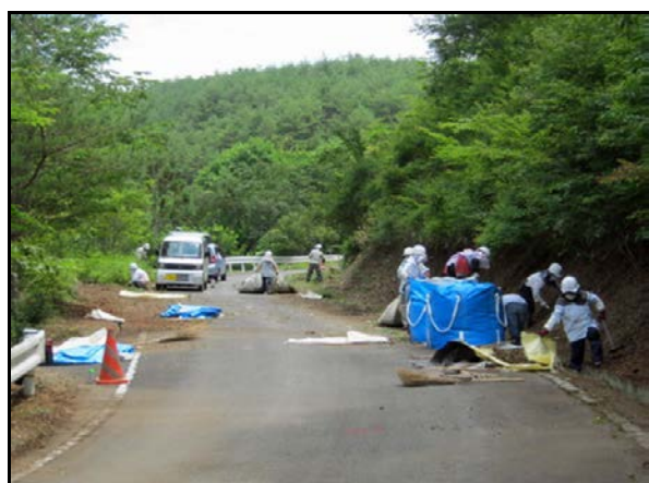
道路除染状況
