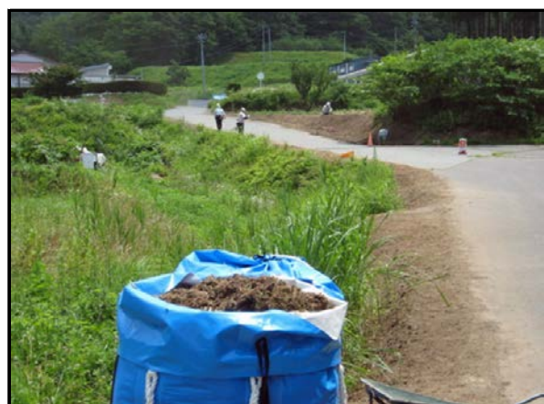
道路除染状況
