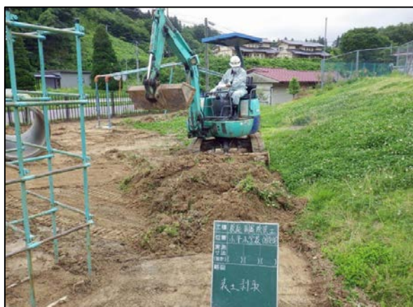
校庭除染工事表土剥取
