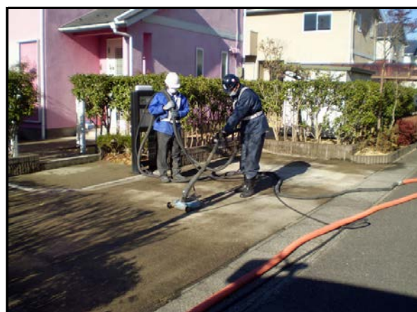
コンクリート洗浄作業
