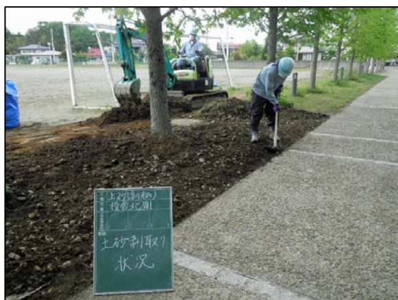
社川小学校除染状況
