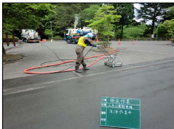
山本公園駐車場除染状況
