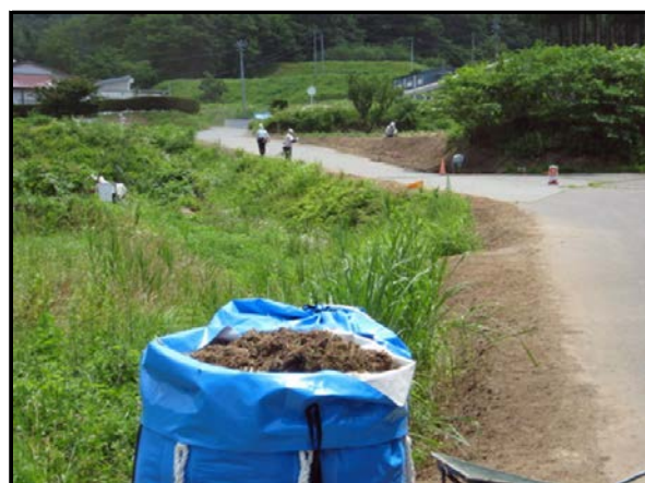
道路除染状況
