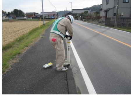
応急補修作業
