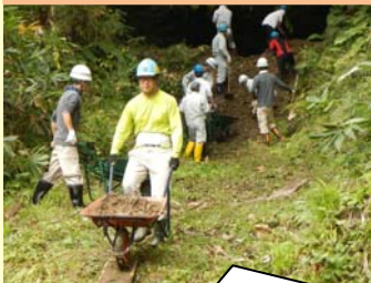
土砂の運搬作業
