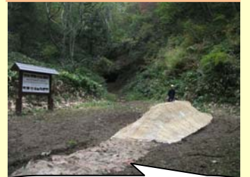
土塁を施工した洞門前広場
