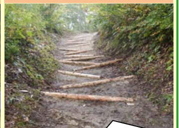
施工後の様子
