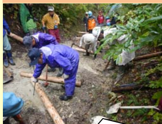
丸太の設置作業
