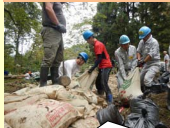
土のう袋の積み上げ
