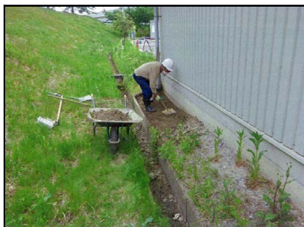
除染(表土剥ぎ取り)
