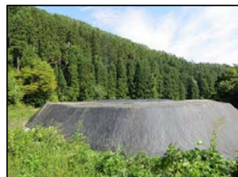
高内仮置場全景
