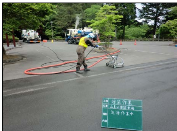
山本公園駐車場除染状況
