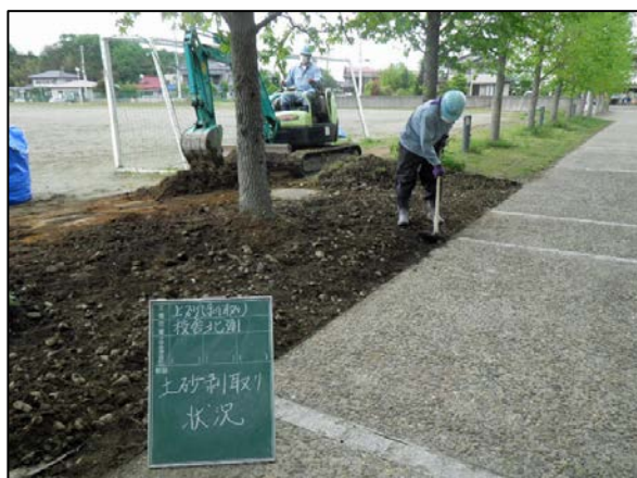
社川小学校除染状況
