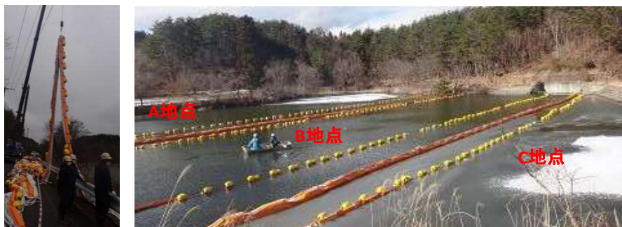
現場写真(左:設置工事、右:工事後(橙線=垂下型,黄色点線=自立型))
