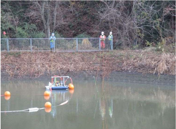
フロート式スクレーパー設置状況
