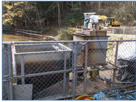
脱水機排水2次処理槽
