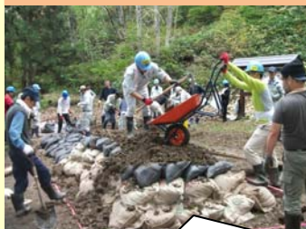
洞門前広場に土壘を施工
