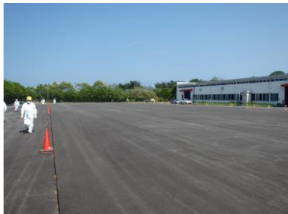
保管場の舗装状況の確認
