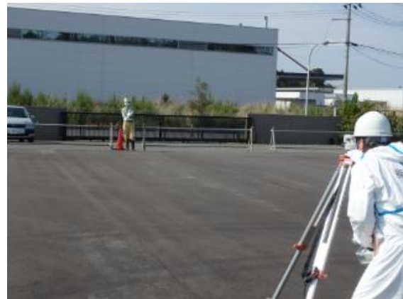
保管場の舗装状況の確認
