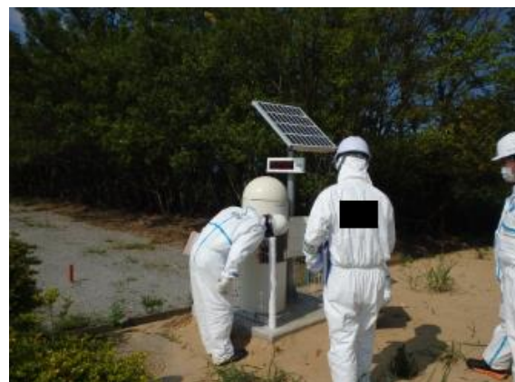
保管場内の常時モニタリング設備の確認
