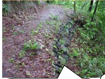
石積工を施工 （平成25年度）
