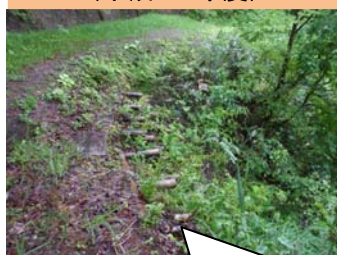
丸太土留工を施工 （平成23年度）
