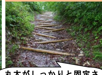
階段落差工を施工 （平成27年度）
