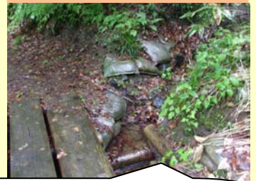
黒いビニール製の土のう袋が積まれている沢止工
