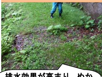
横断側溝・山側側溝を施工 （平成24年度）
