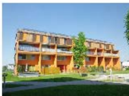
CLTを用いた集合住宅(ウィーン)
