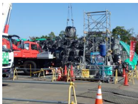
除染土壌等の積下ろし作業確認
