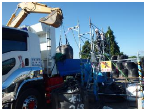
除染土壌等の積み込み確認
