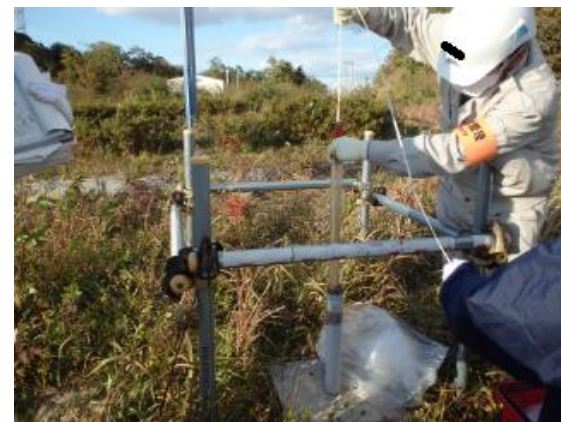
(大熊工区)地下水観測井設置状況確認
