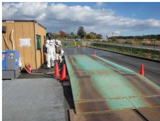
(大熊工区)受入時重量測定施設設置状況確認
