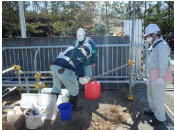
(双葉工区)地下水観測井設置状況確認
