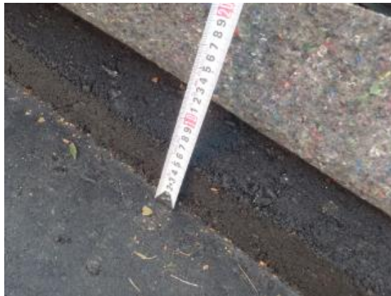
(双葉工区)保管場舗装厚確認
