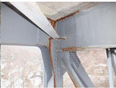
損傷状態:トラス部材の腐食
