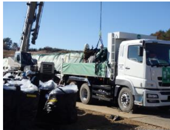
除染土壌等の積み込み確認
