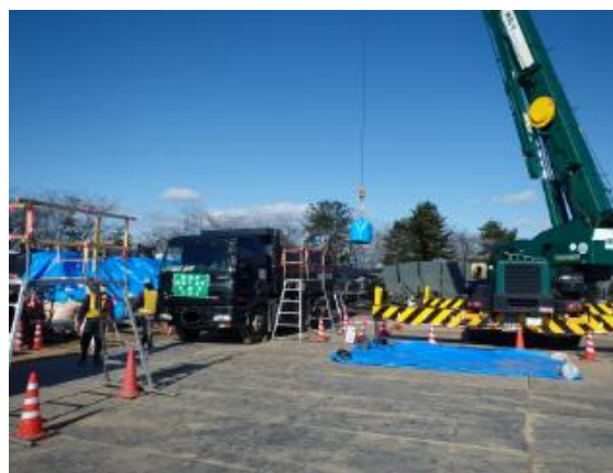
(泉崎村) 除染土壌等の積み確認
