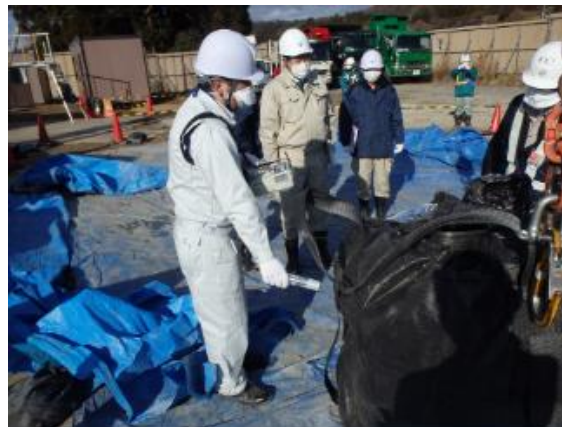
(天栄村) 積み前のフレキシブルコンテナ確認
