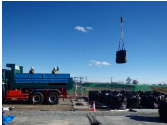
除染土壌等の積み込み確認
