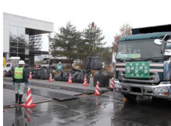
除染土壌等の積下ろし作業確認
