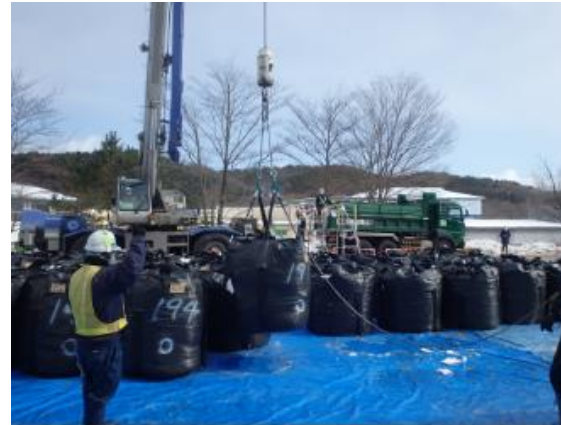
除染土壌等の積み込み確認
