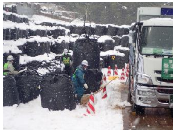
除染土壌等の積み込み確認
